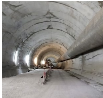
Un'immagine del cantiere Salerno Porta Ovest
